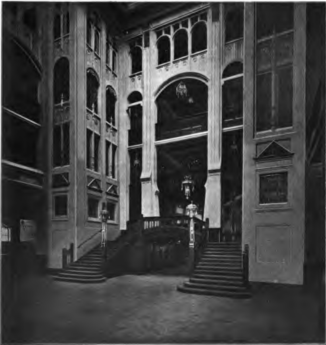
Abb. 1. Mittelhof im Waarenhause „Oberpollinger“, München. Umhüllter Eisenbau. Arch. Heilmann u. Littmann.
